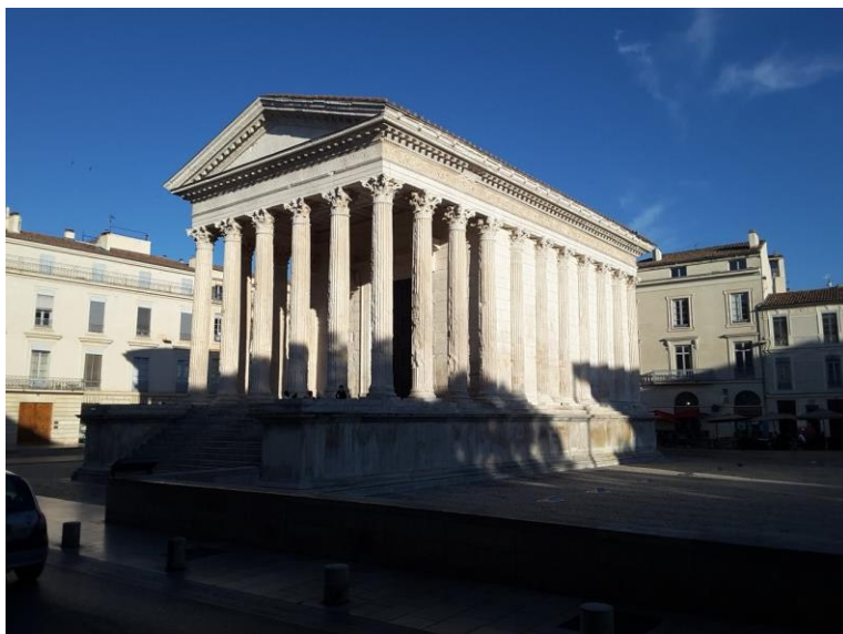
Maison Carrée in Nîmes
